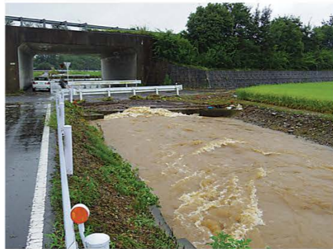
北関東豪雨 荒川（都賀地内） 2015.9.30
