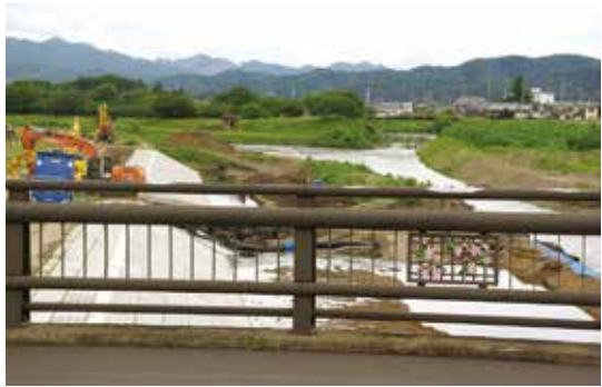
永野川復旧工事・園部町上人橋上流
